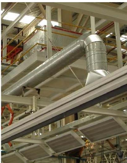
Saugschlitzkanal Typ ATS 2000
