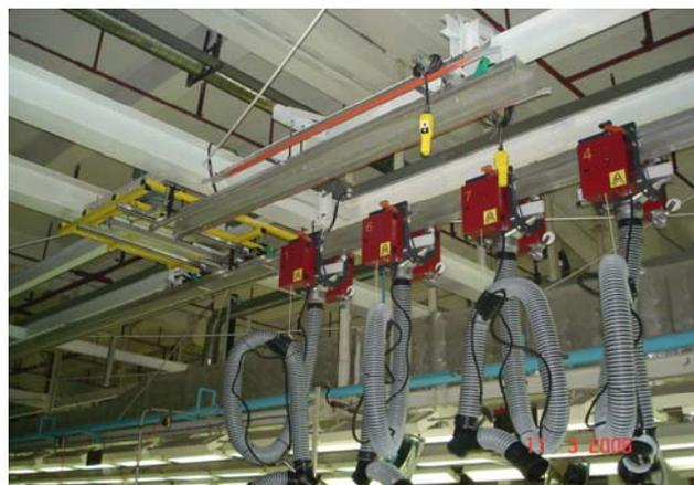
Automatikwagen mit Elektroantrieb und Schlauchaufzug
