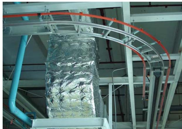
Rückführschiene - Bogen mit Stromschiene
